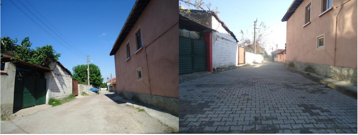
Eşme Yeni Eşme Mahallesi Avanos Sokak Parke Yol Yapım İşi Tamamlandı. 100 mt uzunluğunda 5 mt genişliğindeki yola 500 m 2 parke 200 mt Bordür kullanıldı.
