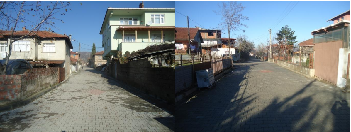
Eşme Yeni Eşme Mahallesi Göl Yolu Sokak Parke Yol Yapım İşi Tamamlandı. 275 mt uzunluğunda 6 mt genişliğindeki yola 1650 m 2 parke 550 mt Bordür kullanıldı.
