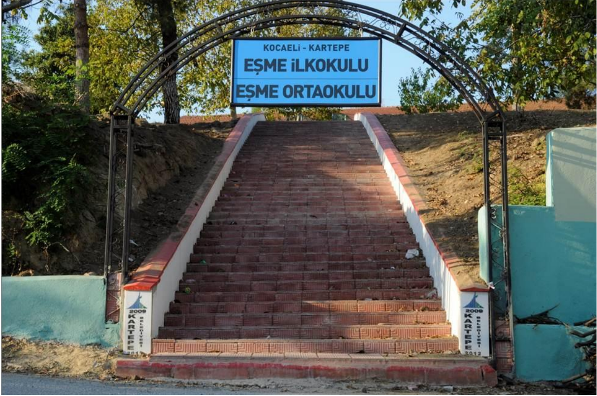
Eşme İlköğretim Okulu Merdivenleri Yapımı
