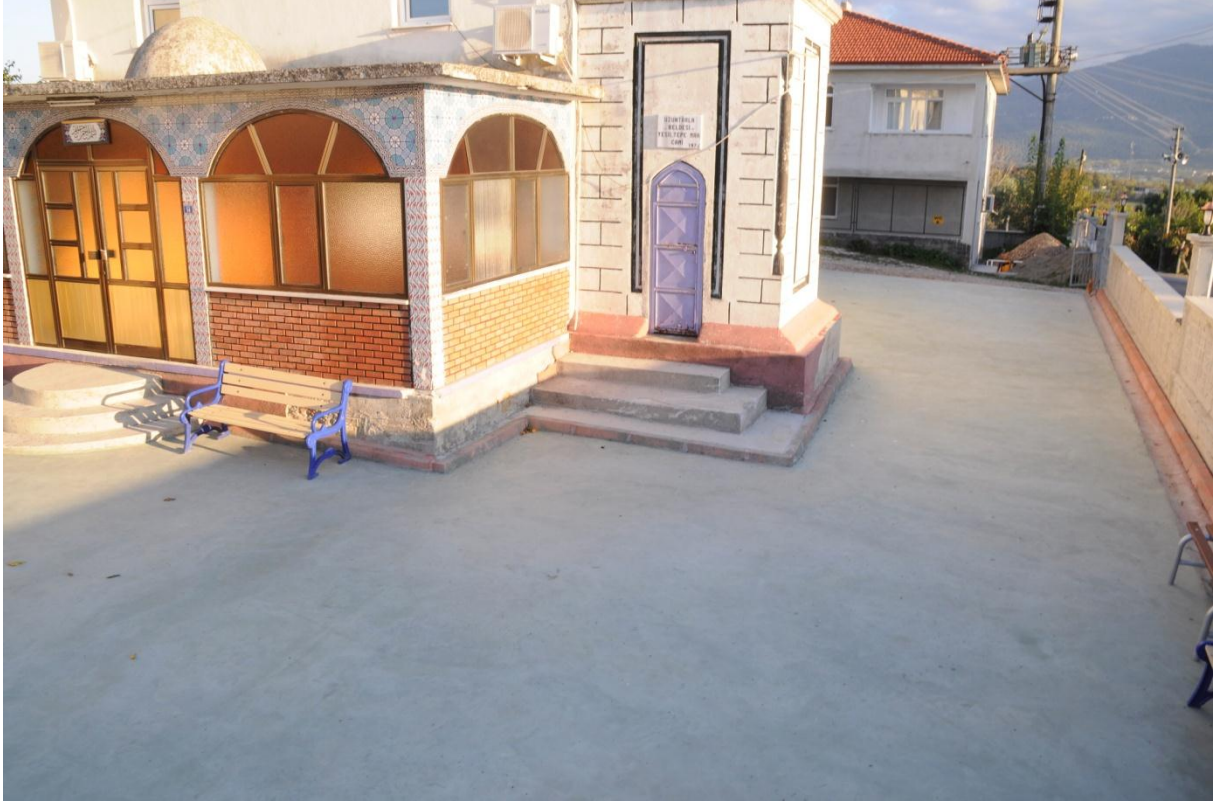
Uzuntarla Yeşiltepe Mahallesi Cami Çevre Düzenlemesi
