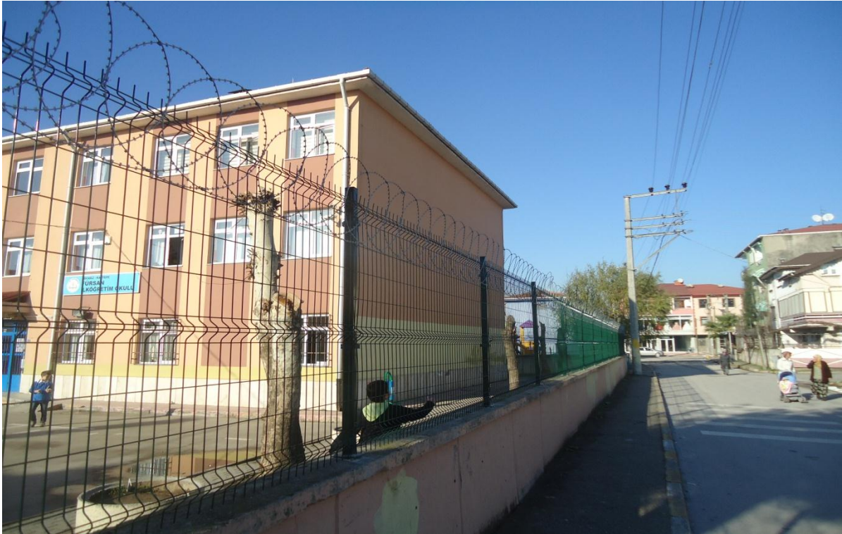
Fursan İlköğretim Okulu Duvarlarına Panel Çit Yapılması
