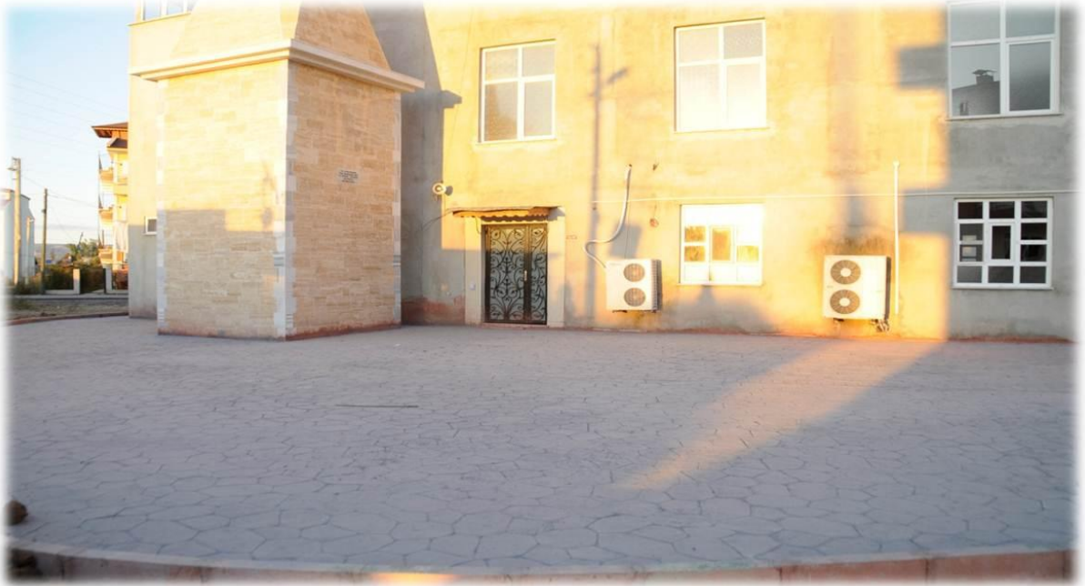
Uzunçiftlik Konak Mahallesi Çevre Düzenlemesi
