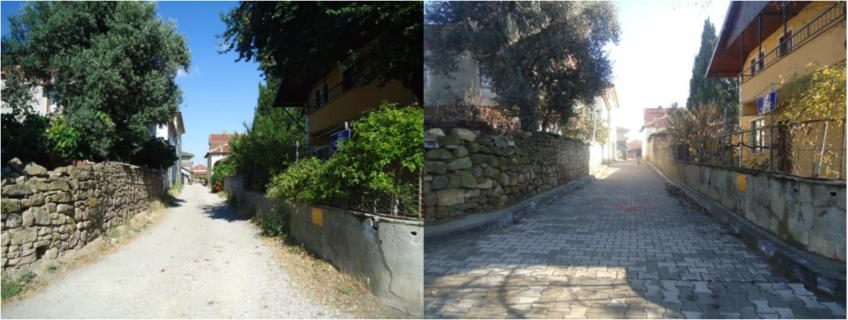
Eşme Yeni Eşme Mahallesi Özbek Sokak Parke Yol Yapım İşi Tamamlandı. 102 mt uzunluğunda 5 mt genişliğindeki yola 510 m 2 parke 204 mt Bordür kullanıldı.
