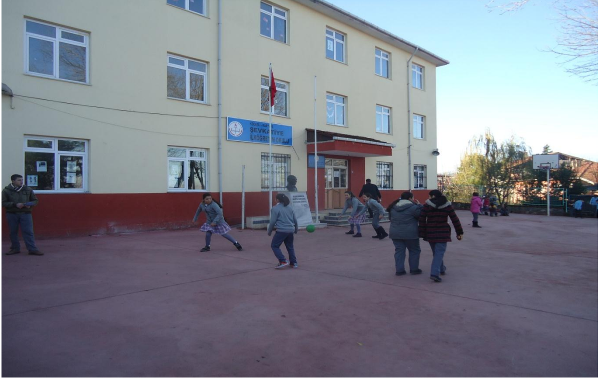
Arslanbey Şevkatiye İlköğretim Okulu Bahçesine Süpürgeli Beton Yapılması
